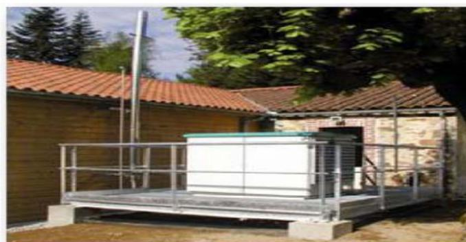
**Figure 1.6.** Photographie de la pile à combustible de type PEMFC qui est située à Limoges dans le cadre du projet EPACOP
